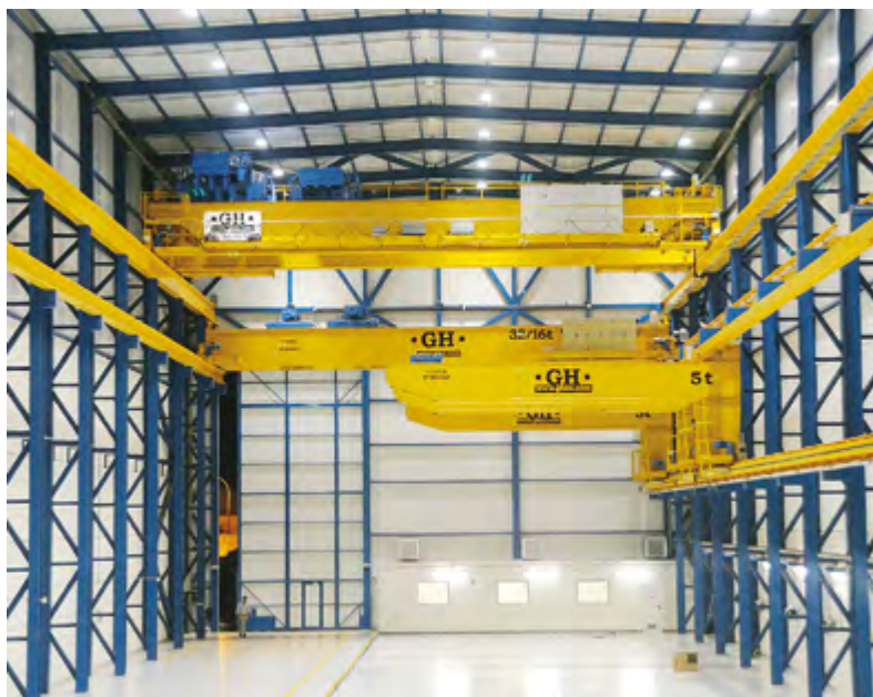
Pont roulant bipoutre et grue véloce
